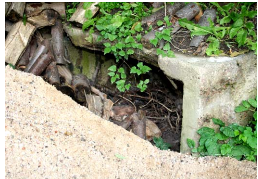
Betonmagasinet er næsten helt tildækket
