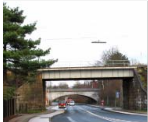
Jernbanebroen over Ermelundsvej
