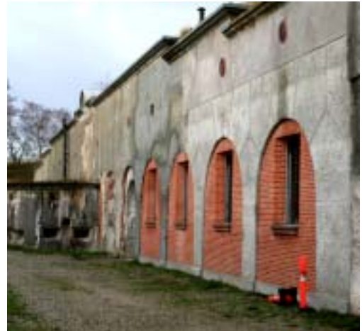
Den restaurerede del
